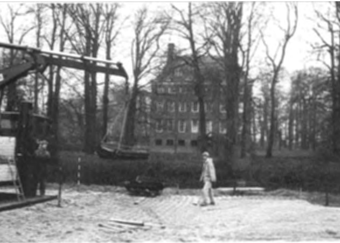
Vorbereidingen bij de bouw van een dam in de buitengracht (herfst 1988) foto: H.F. Rotgans - v.B.
