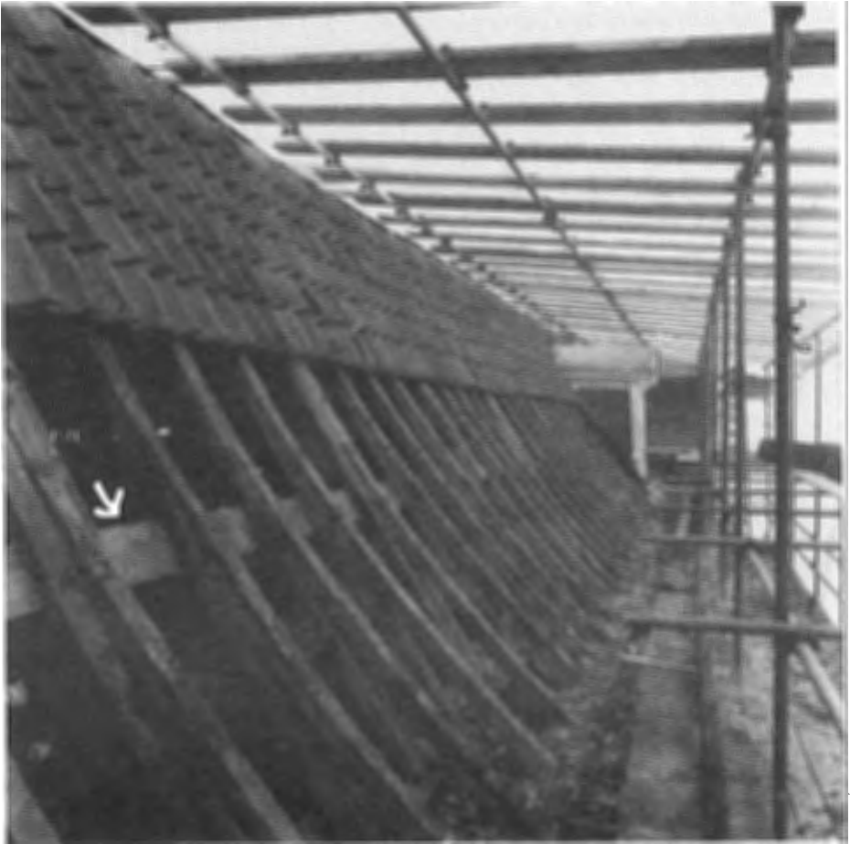
De voet van het westelijke dakvlak van het middendeel tijdens de restauratie. Op de gording is een van de telmerken zichtbaar.
