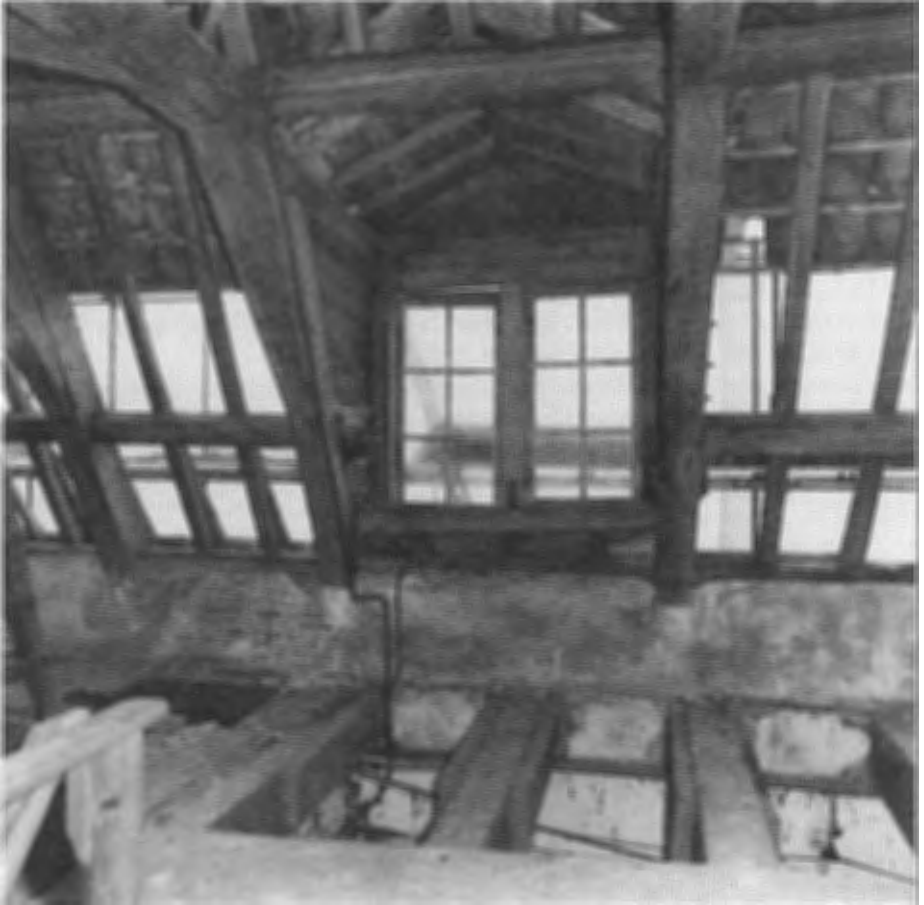
Zolder van het middendeel met een van de dakkapellen (aan de westzijde) tijdens de restauratie.
