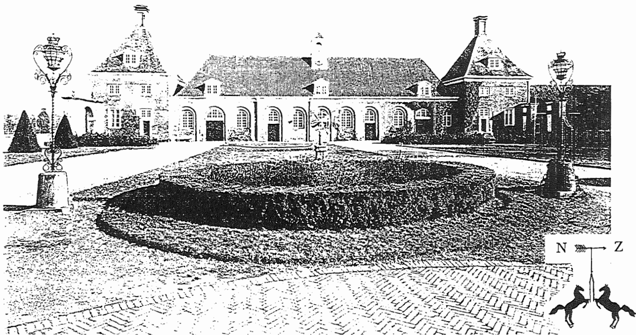
Het stalgebouw gezien vanaf het kasteel.
