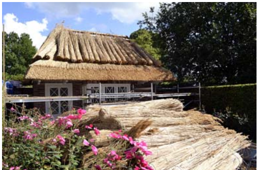
De restauratie van het kinderkuisje in volle gang
